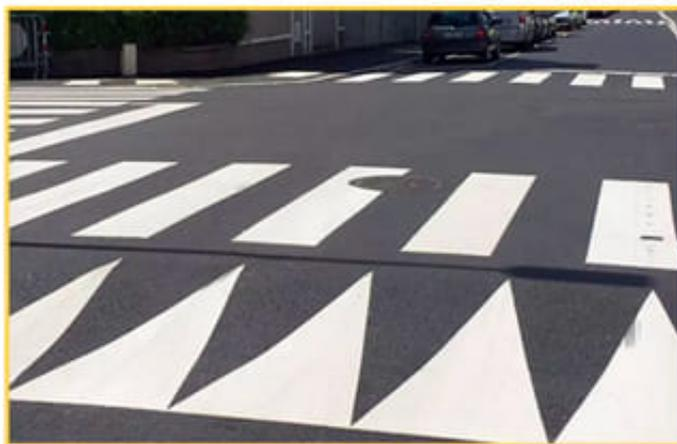
L'utilisation de thermocollés plutôt que de [peinture routière](#) permet de mettre en place rapidement et durablement une signalisation au sol également appelée signalisation horizontale.
